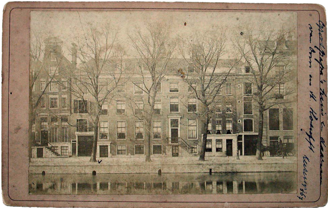
15 - Foto van de gevel Keizersgracht 565/567 na de verbouwing in opdracht van Anna Maria Backer-Rendorp in 1852 waarbij onder andere het bordes werd verwijderd, ca. 1910
